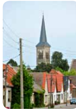
An Großwirschlebens Kirche ist die Sanierung beendet. Foto: Pülicher.
